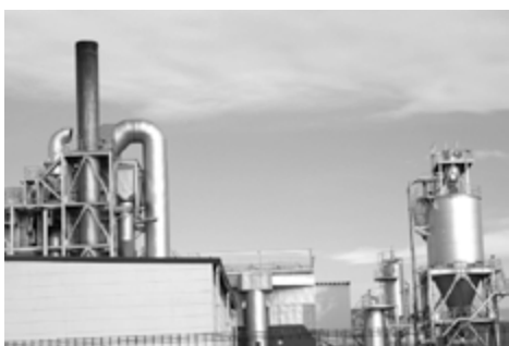
バイオパワーふくしま発電所の煙突、試験運転中でも茶褐色(2025.5.18撮影)
