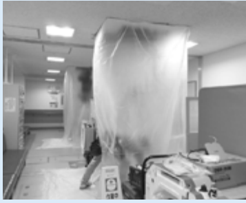
病棟での工事の様子
