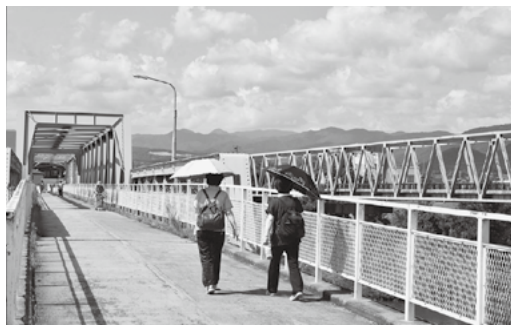
伊達橋歩道橋（旧伊達橋）
