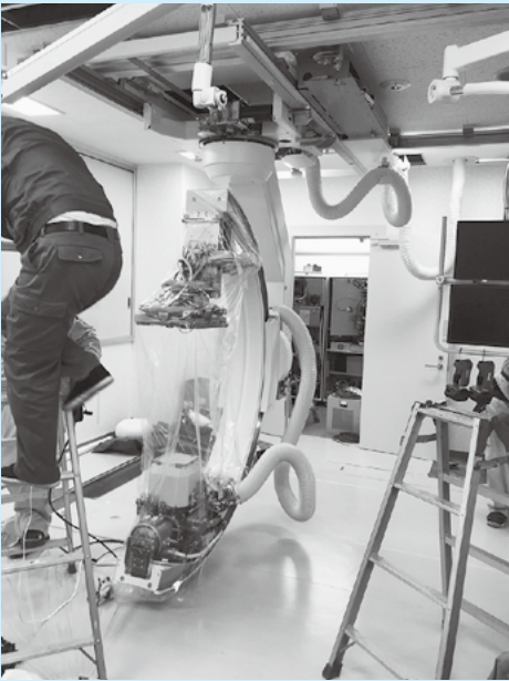
工事中の写真です。フラットパネルというタイプの最新型の画像撮像装置になりました。
