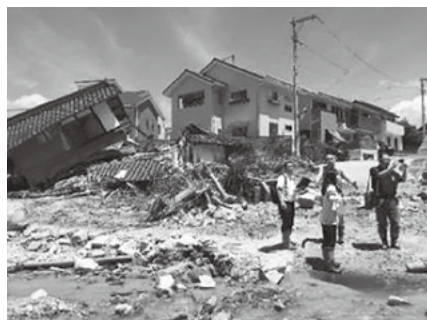
口田南・民家崩落現場
