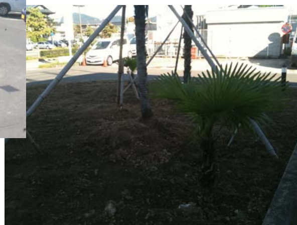
(下) 芝撤去直後の写真 このあと土を入れて整地しました
