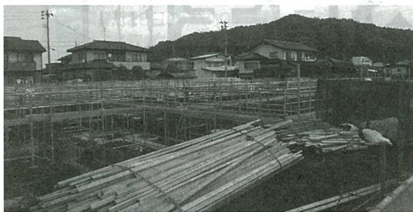
建設工事も着々と進んでいます(医療生協わたり病院北側)
